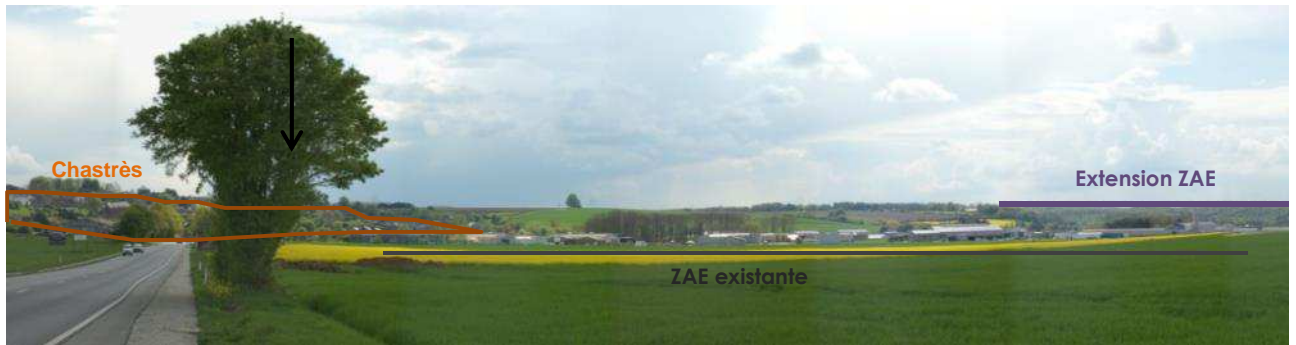
Figure 47 : Photo 3 - Vue depuis la N978 en venant de l'est (N5) - (Photo CSD, avril 2014)
