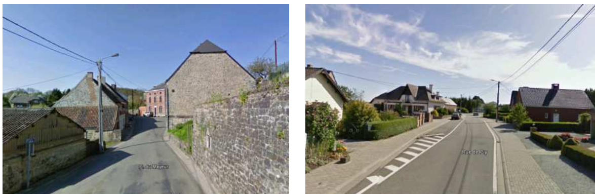
Figure 50 : A gauche : vue du centre de Pry / A droite : vue des dernières extensions de Pry vers la N978 (source : Googlearth)
