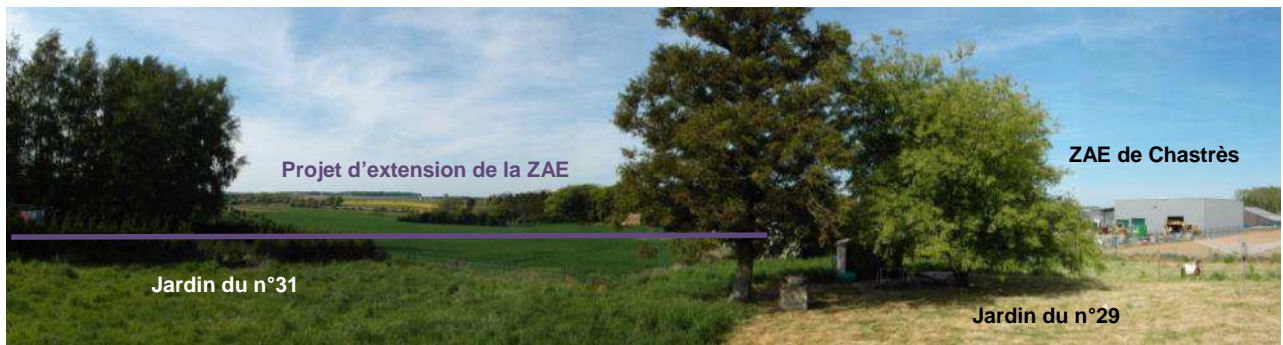
Figure 135 : Photo 8 - vue vers la ZAE et le projet d'extension à l'arrière de la maison n°29 et du n°31 rue des Barrages (N978) à Chastrès - (Photo CSD, avril 2014)
