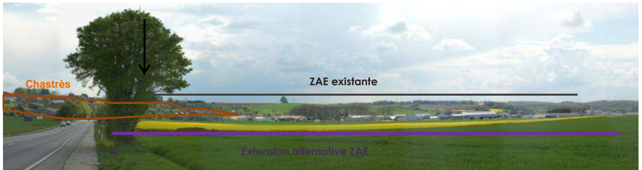
Figure 170 : Photo 3 - vue depuis la N978 en venant de l'est (N5) - (Photo CSD, avril 2014)
