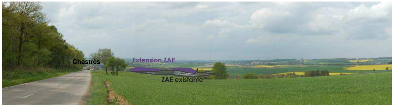
Figure 126 : Photo 2 - vue depuis la LVR 1 au niveau de la N932 à Chastrès Pry - (Photo CSD, avril 2014)
