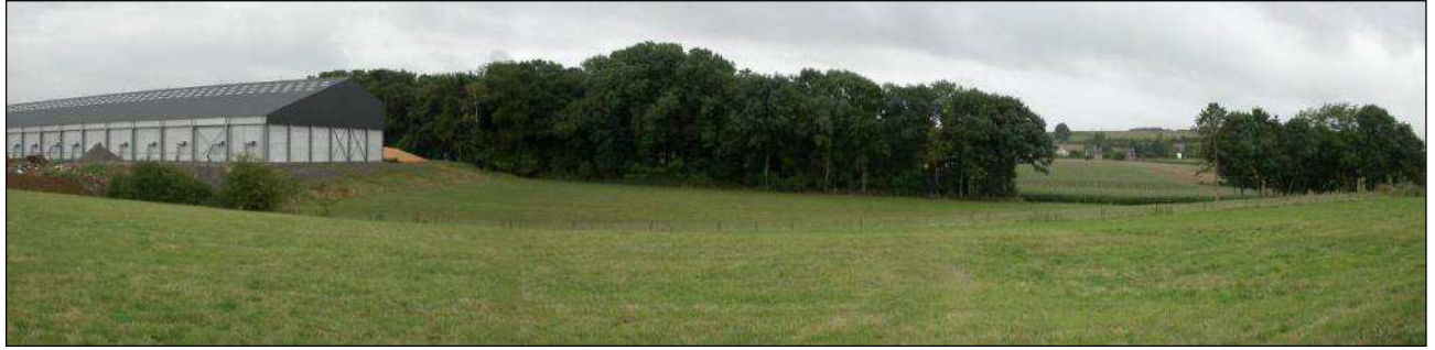
Figure 40 : Vue du bosquet feuillu de l'extension depuis la prairie
