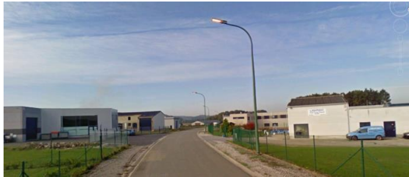
Figure 26 : Vue du bâti au sien de la partie de la ZAE déjà mise en œuvre –rue des Meules (source : Googlearth)
