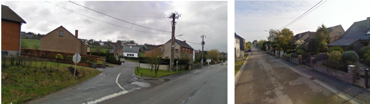
Figure 22 : vue sur le bâti route des Barrages (N978) et St-Donat (Source : google earth)
