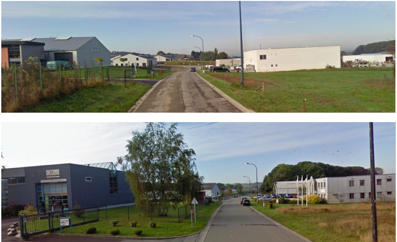
Figure 24 : Exemples d'entreprises allée JF Kennedy
